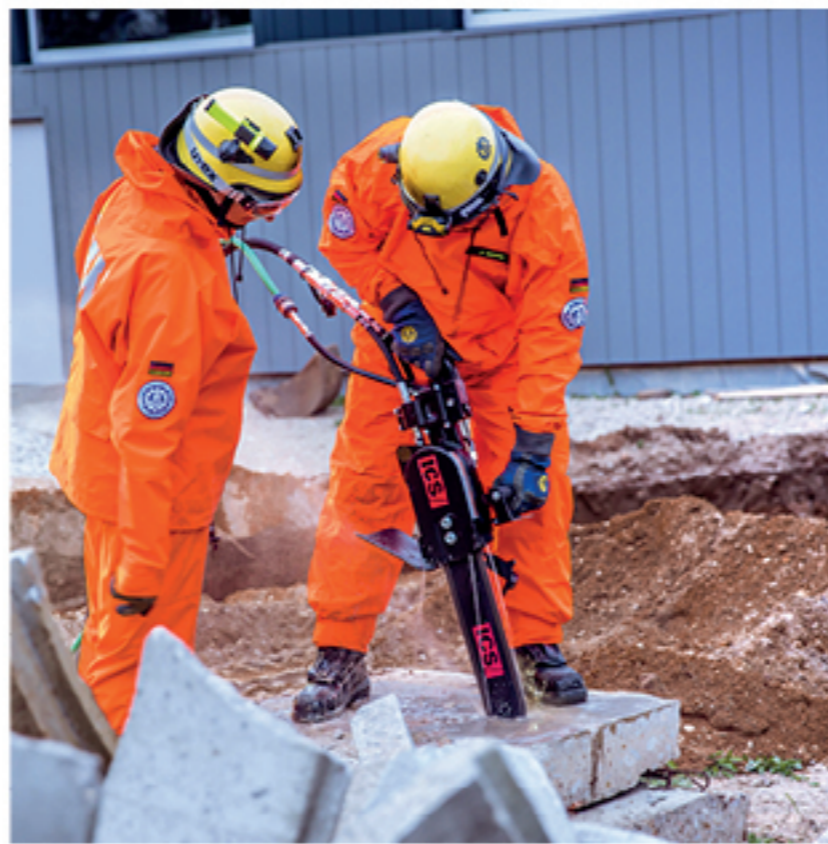
Hier haben sie zum ersten Mal mit ihrer neuen Betonkettensäge gearbeitet. Cool!
